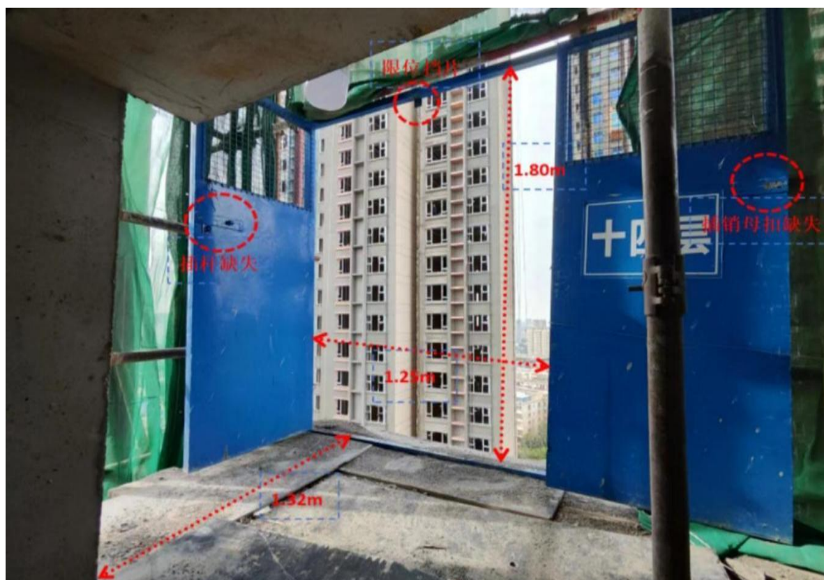
图 1：卸料平台入口图
